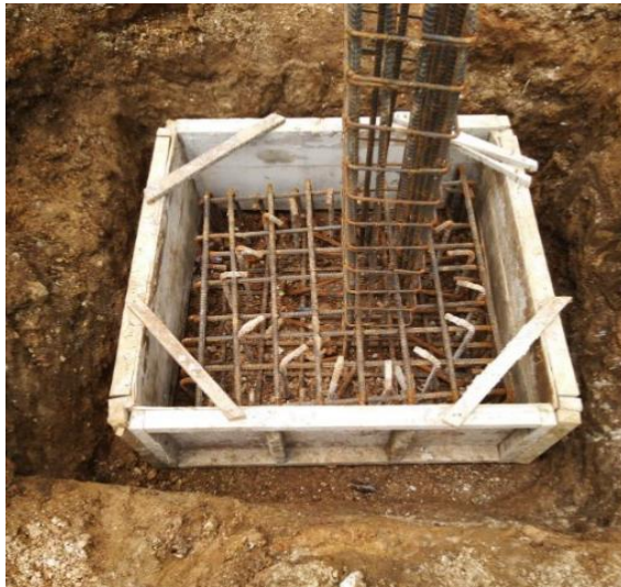
Gambar 5. Eksentrisitas pada saat Penulangan Besi
